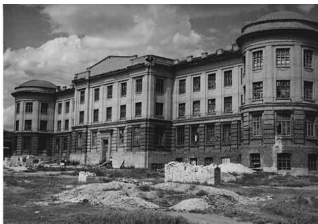
Рис. 16. Завершающий этап строительства детского корпуса в клиническом городке СМИ (ныне — Университетская клиническая больница № 1 им. С.Р. Миротворцева СГМУ), 1957–1959 гг.
