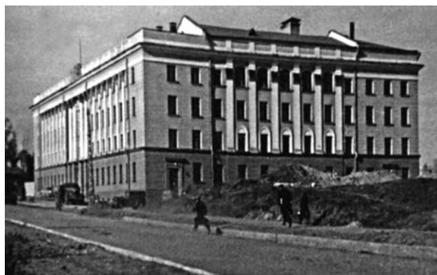
Рис. 1. Здание главного корпуса, пр. Ленина, 40, 1954 г. Источник: https://m.barneos22.ru/files/photos/57d3055d4af64.jpg Fig. 1. Main building, 40 Lenin Avenue, 1954 Source: https://m.barneos22.ru/files/photos/57d3055d4af64.jpg
